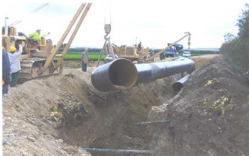
LAVORI DELL'ACQUEDOTTO DEL LOCONO
